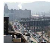
Alaskan Way Viaduct
